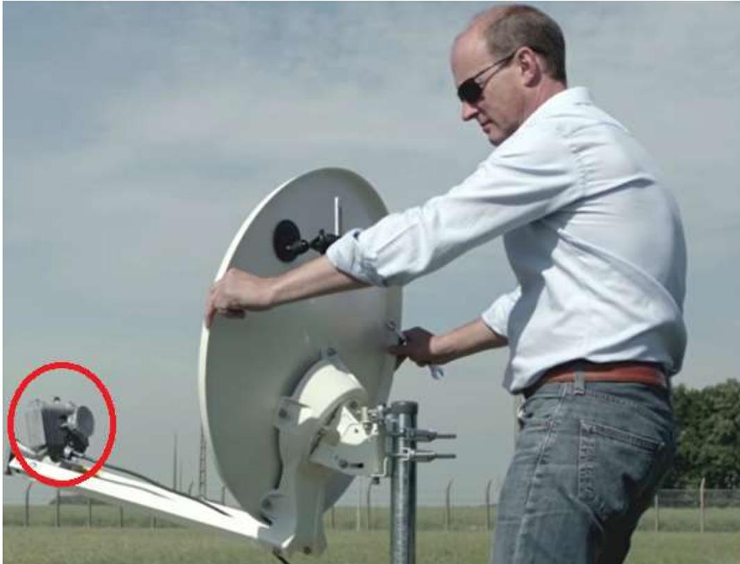
Während der Schüssel-Ausrichtung überprüfen Sie die Elevationsergebnisse und bewegen Sie den Satellitenhalter.
